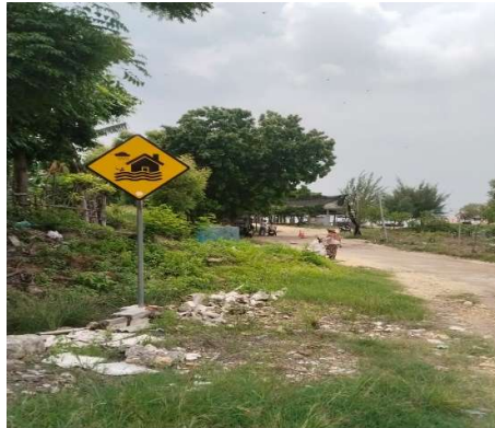
Gambar 2. Kondisi Jalan Pantai Pesisir Jumiang.
